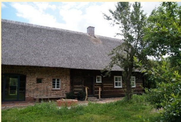
Renoviertes Annemarie-Schulz-Haus Foto: Frank Kuba
